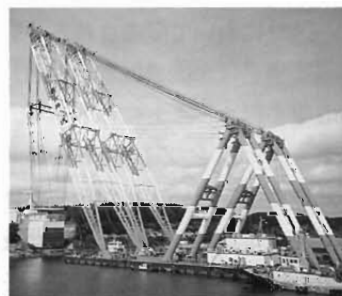
写真5 原子炉室を海上クレーンにより原子炉保管棟へ移送
