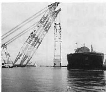
写真4 原子炉室を「むつ」より海上クレーンにより吊り上げ移送
