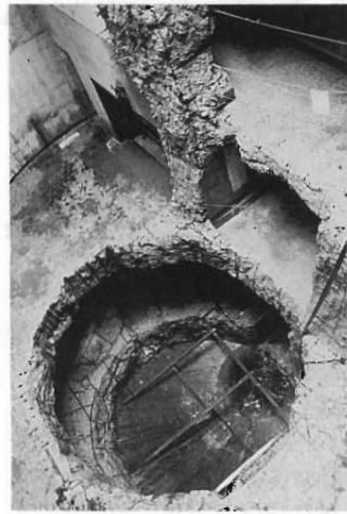
写真4 生体遮蔽体撤去後 (上部から見た格納容器の内部)
