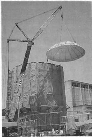
写真2 原子炉格納容器解体 (平成7年5月23日)
