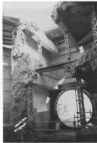
写真5 生体遮蔽体撤去後 (機器搬入口付近)
